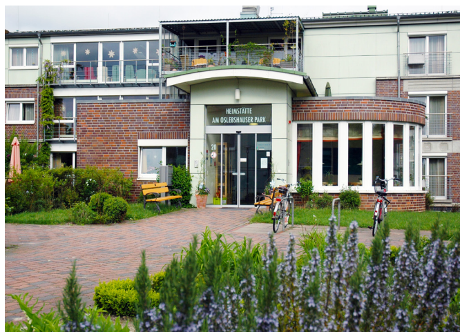
Eingang zur Heimstätte am Oslebshauser Park mit Demenzgarten (Vordergrund)
