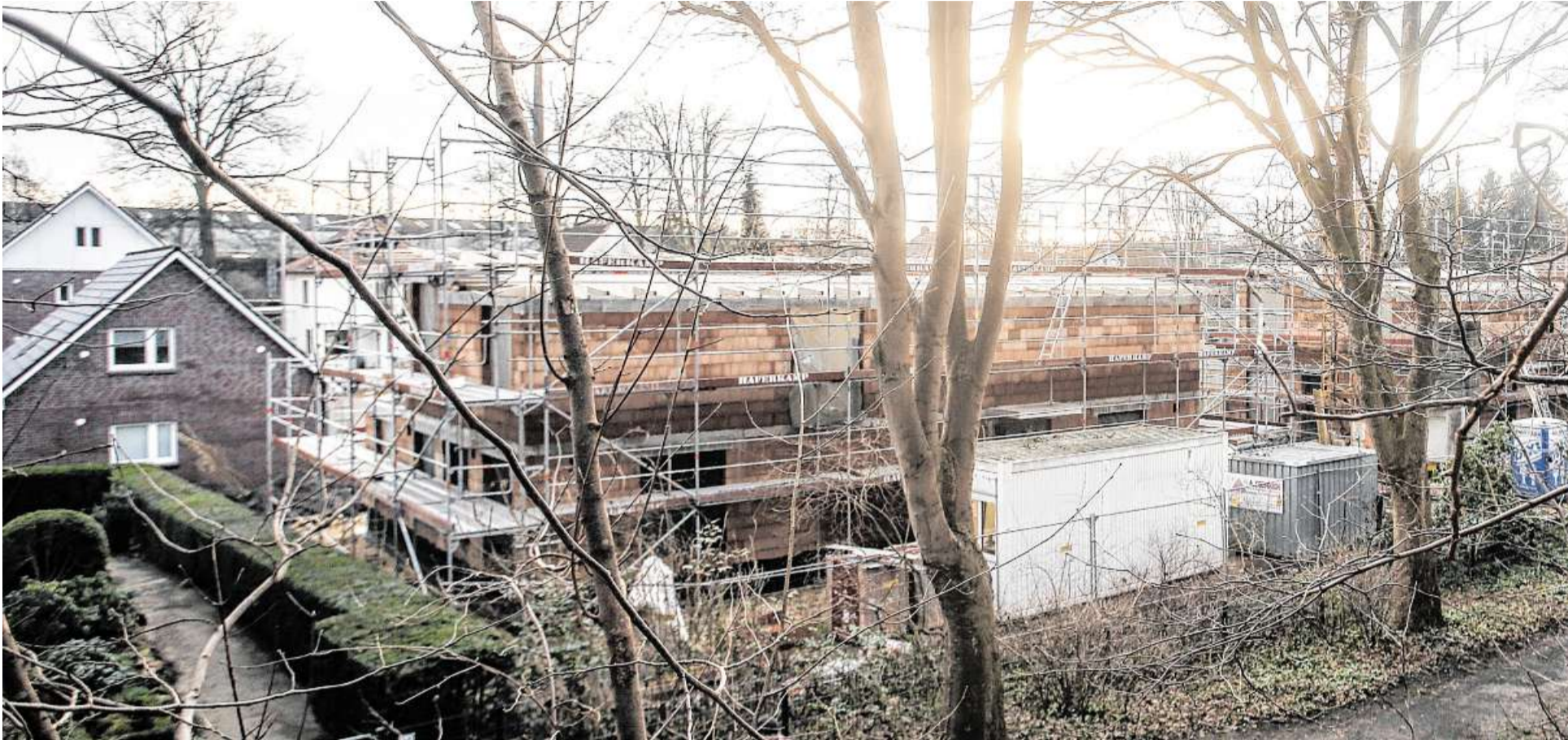
Die beiden Häuser für Kinder entstehen noch. Sie sollen mit der Einrichtung für Geflüchtete und für psychisch kranke Menschen im Spätsommer eingeweiht werden.
